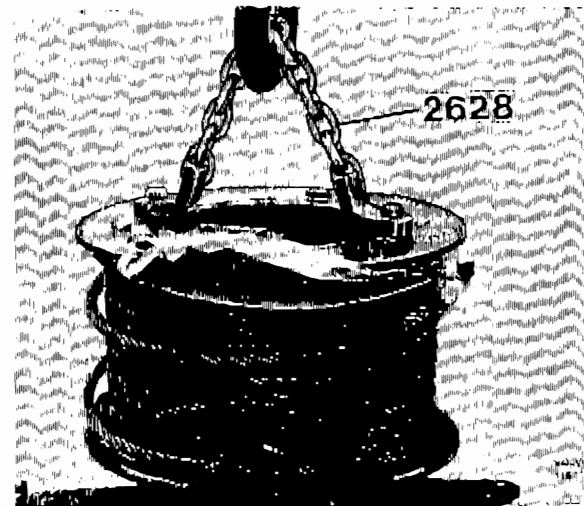
Bild 50. Borttagning av kabeltrumma
